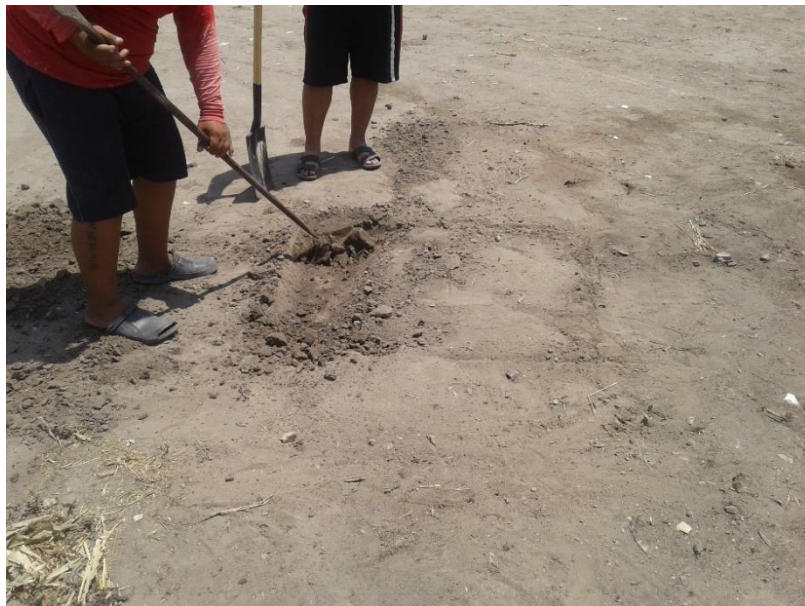
Fotografía 4: Inicio de excavación para calicatas a cielo abierto
