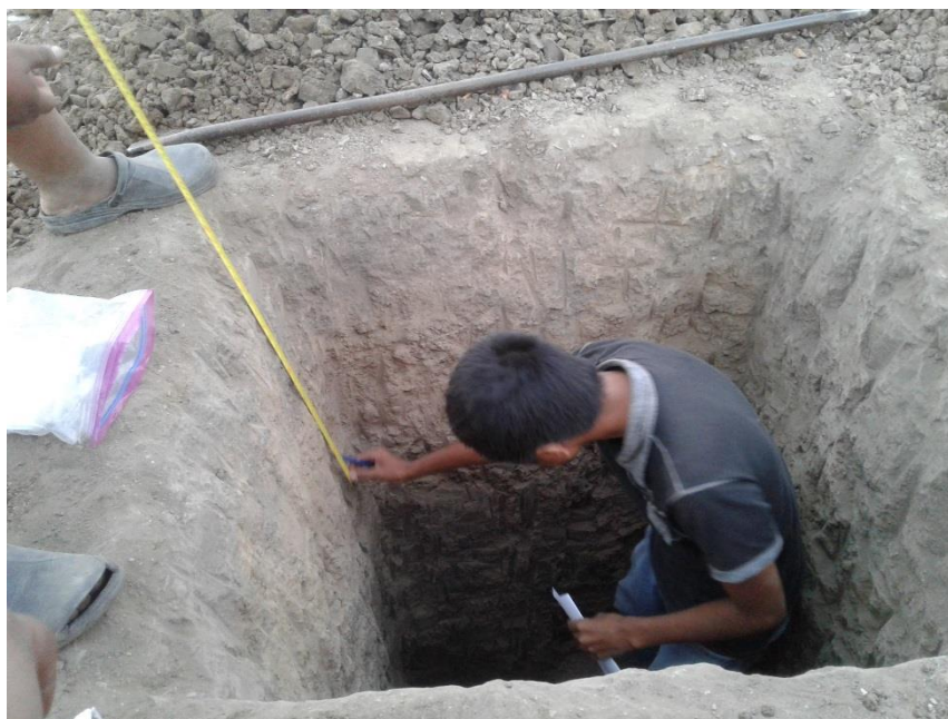
Fotografía 6: Medición de estratos de calicatas
